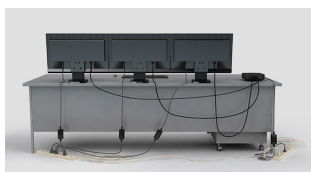
Obvyklé řešení: nepřehledná kabeláž
